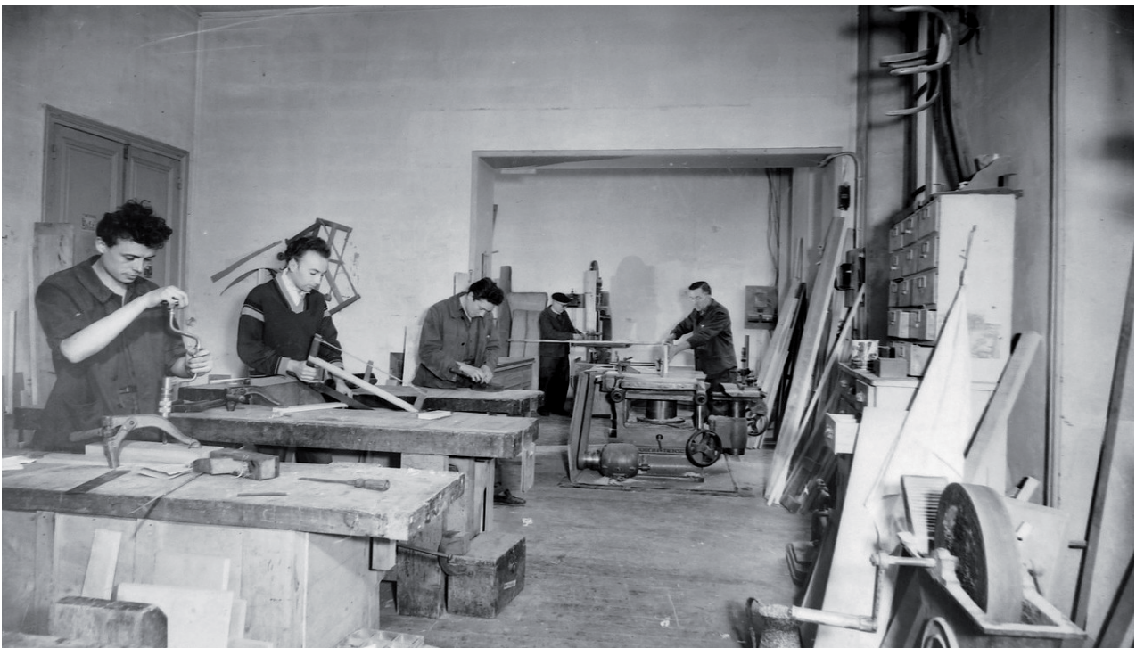
58. Services et ateliers (standard, imprimerie, menuiserie) du ministère de l'Intérieur [1956]
