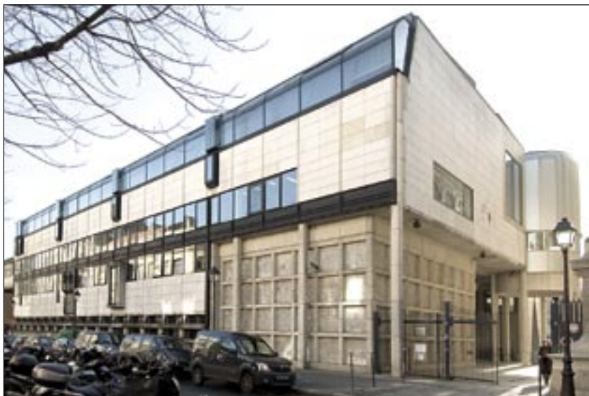
La façade du CARAN sur la rue des Quatre-Fils et l'entrée du public.
