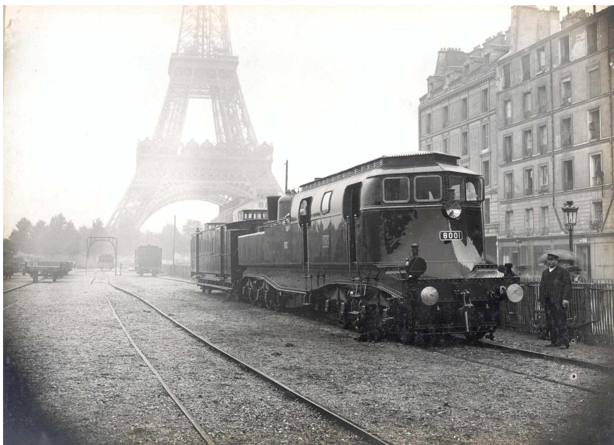
Illustration 1. Essais de la locomotive électrique Heilmann n°2 dite « 8001 » (1897). Cote 2005 060 03 7.
